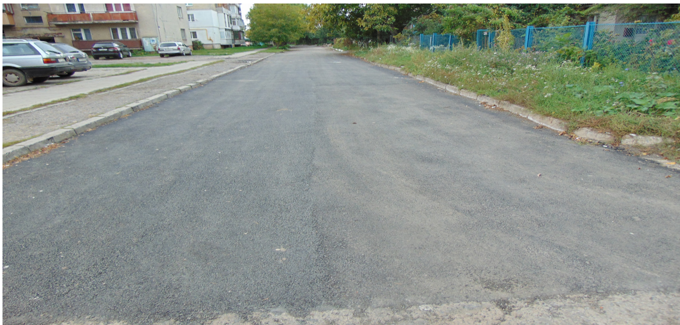
Ремонт дорожнього покриття у провулку Прикордонників
